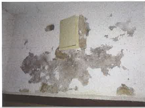
6. kép: Festékleválás a falon
